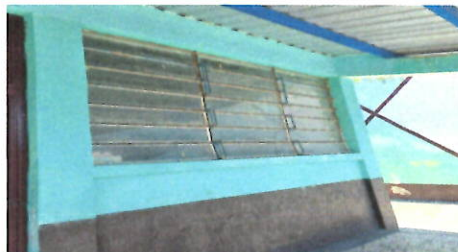
Foto 2: Ventanas y balcones
