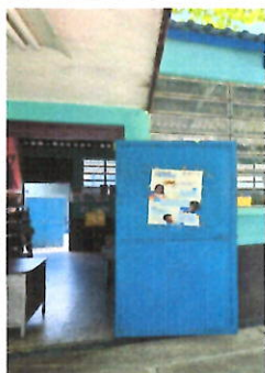
Foto 5: Mantenimiento de puerta
