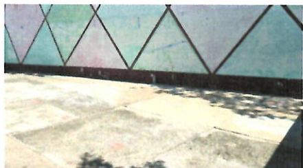
Foto1: Pintura en paredes exteriores.
