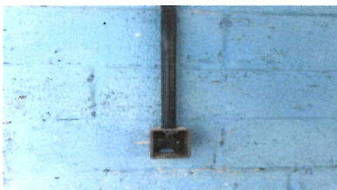
Foto 4: Reparacion del sistma electrico
